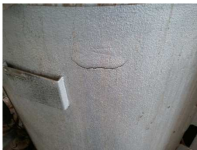
Figura 18c: Máquina com a resina danificada, requerendo manutenção da aplicação. Fonte: fotos do autor.
